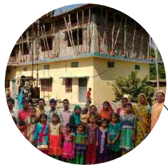
Bau einer Unterkunft für Schulfrauen aus dem Dschungel
